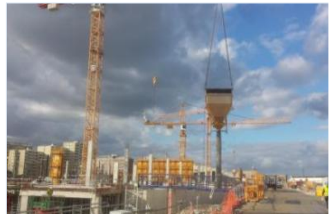
Chantier de Chapelle International - Photo : A. Heitz-23/02/2016
